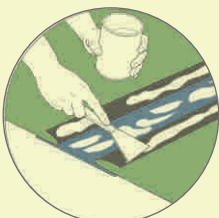
STEP 06 Pour the glue on the joint tape
